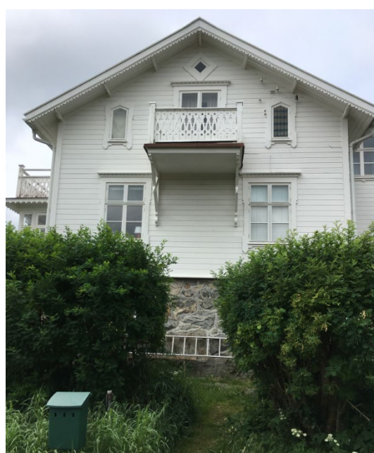
Byggnad nordväst om planområdet
